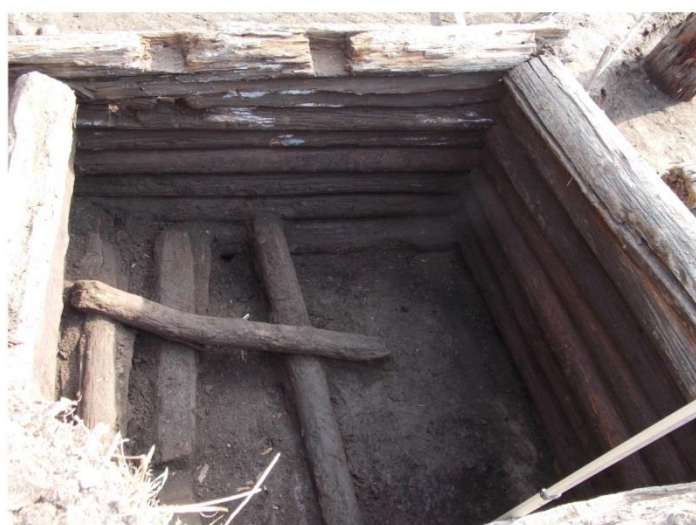
Рис. 2. 1 – погреб «на отлете»; 2 – погреб рядом с избой; 3 – лаги пола и врубки перекрытия во втором погребе
