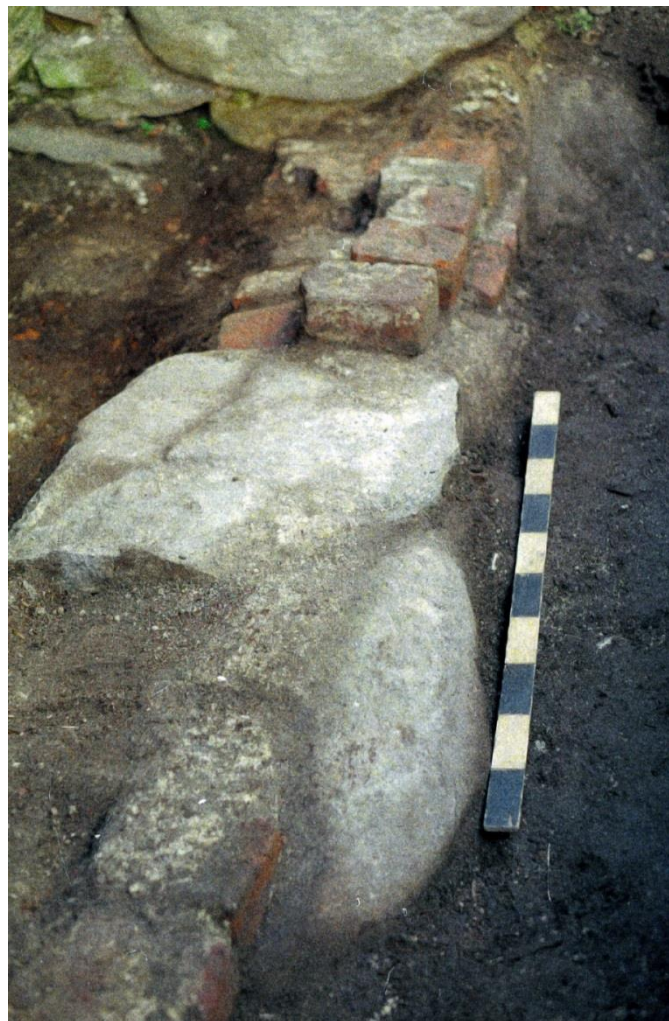
Рис. 5. Основание стены перед входом в печуру. Расчищенный валунный цоколь с плоским камнем низа дверного проема и остатками кирпичной кладки. Вид с севера
