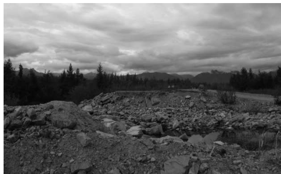
Рис. 2. Состояние насыпи после прохождения паводка (2010 г.)
