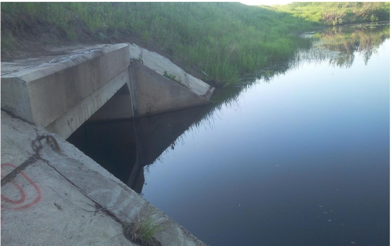
**Рис. 12. Протоки, пересекаемые недостроенной левобережной магистралью, с сооружениями для перетока воды**
