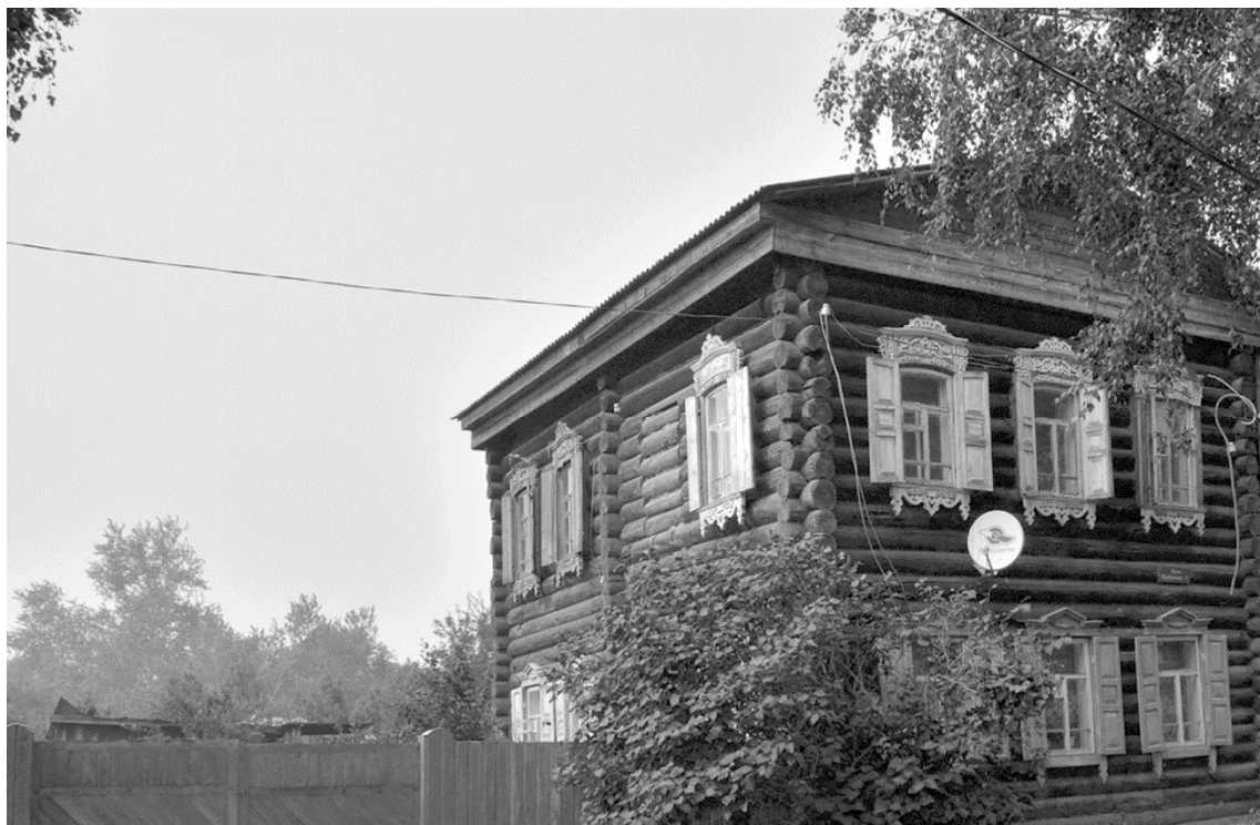
Рис. 2. Здание по ул. Карбышева, 8 (фотография авторов, 2016 г.)
