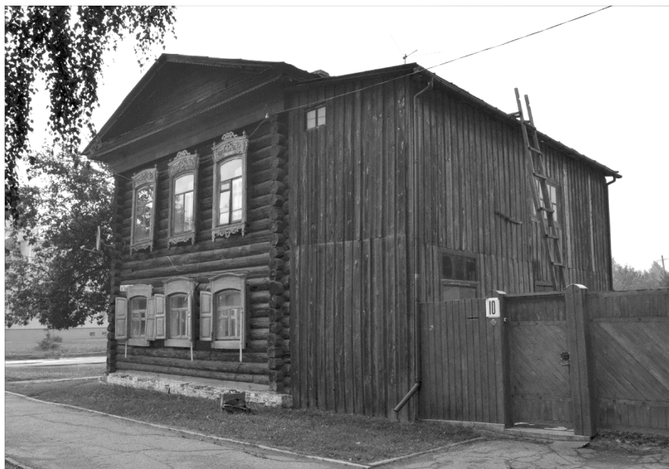
Рис. 3. Здание по ул. Карбышева, 10 (фотография авторов, 2016 г.)
