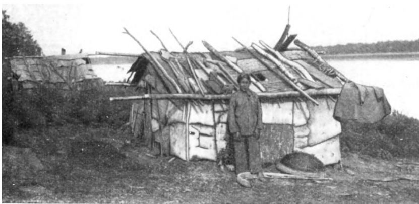
Рис. 32. Ульчский четырехстенный летник, крытый корой давра [1.2.26] (Попов 1961: 189; Левин, Потапов 1956: 821)
