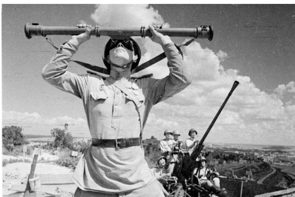
Рис. 10. Однометровый зенитный дальномер ЗДН-1 [12]
