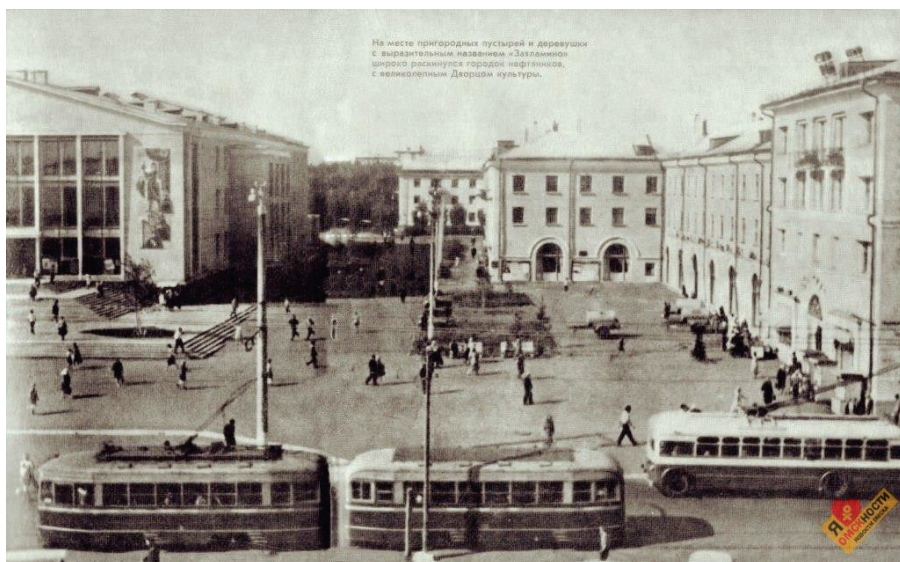
Рис. 6. Фото Д.Д. Ухтомского. ДК Малунцева. 1968 г. Источник: Удивлю. Галерея изящных решений. URL: http://удивлю.рф (дата обращения: 27.05.2019)
