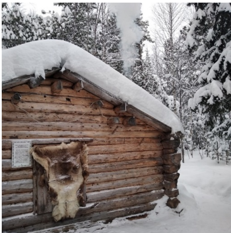
Рис. 1. Войкарский комплекс. Зимний дом с земляной крышей. Фото Н.В. Золотаревой
