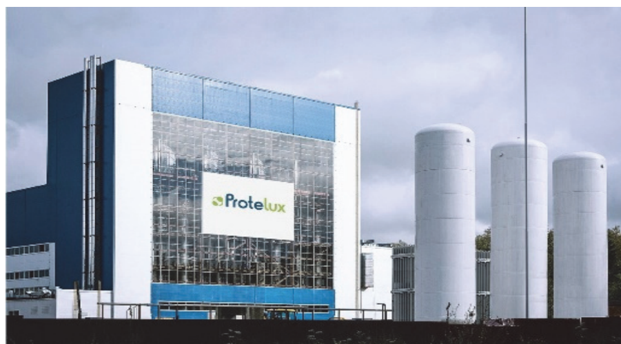
Рис. 4. Завод по производству гаприна, Protelux, г. Ивангород, Ленинградская область
