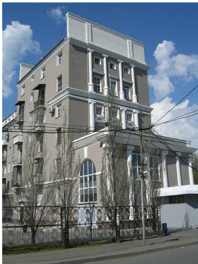
Рис. 4. Жилой комплекс соцгорода вагоностроительного завода. 1936 г. Фото: Дом «дураков» и его скверное прошлое : timyan_omsk – ЖЖ (livejournal.com)
