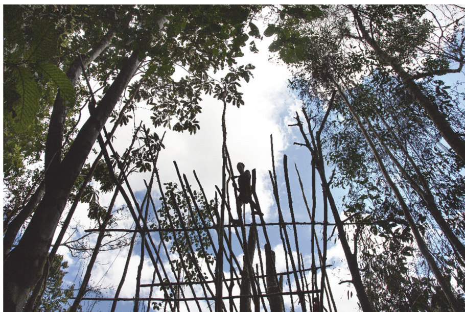
Рис. 1. Они создает каркас первого дома khaim . Четвертый день от начала строительства. Февраль 2014 г. Фото автора
