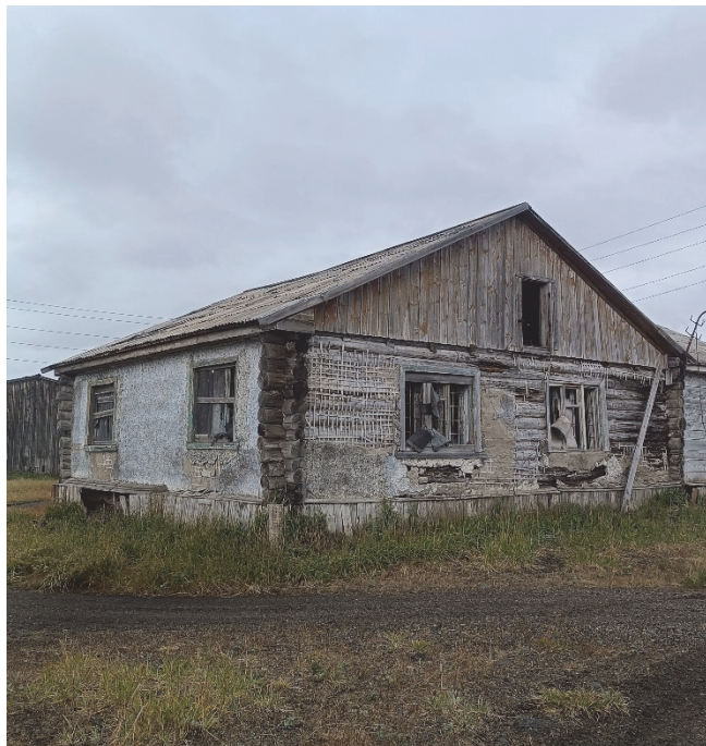
Рис. 3. Типовой рубленый жилой дом 1960-х гг. постройки в селе Уэлькаль. Фото автора
