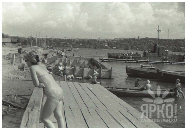
Рис. 9. Вид на строящуюся набережную Ижевского пруда
