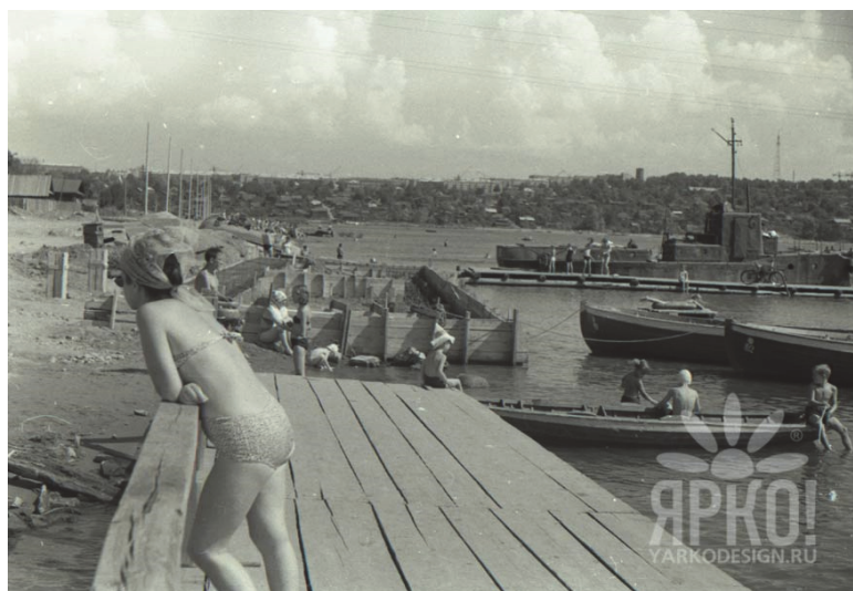
Рис. 9. Вид на строящуюся набережную Ижевского пруда
