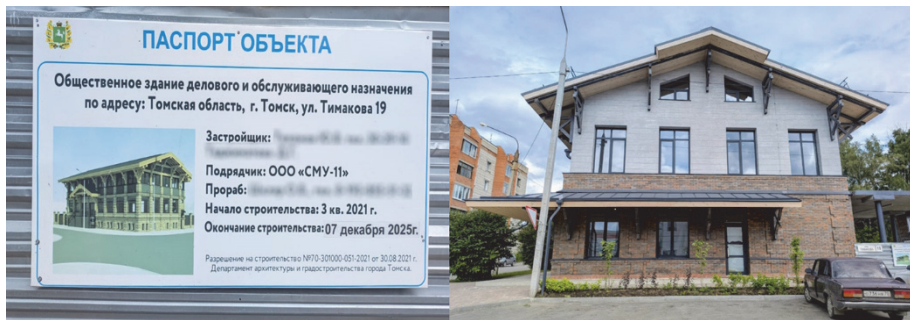
Рис. 4. Строительство нового здания на ул. Тимакова (ПМА 2025а)
