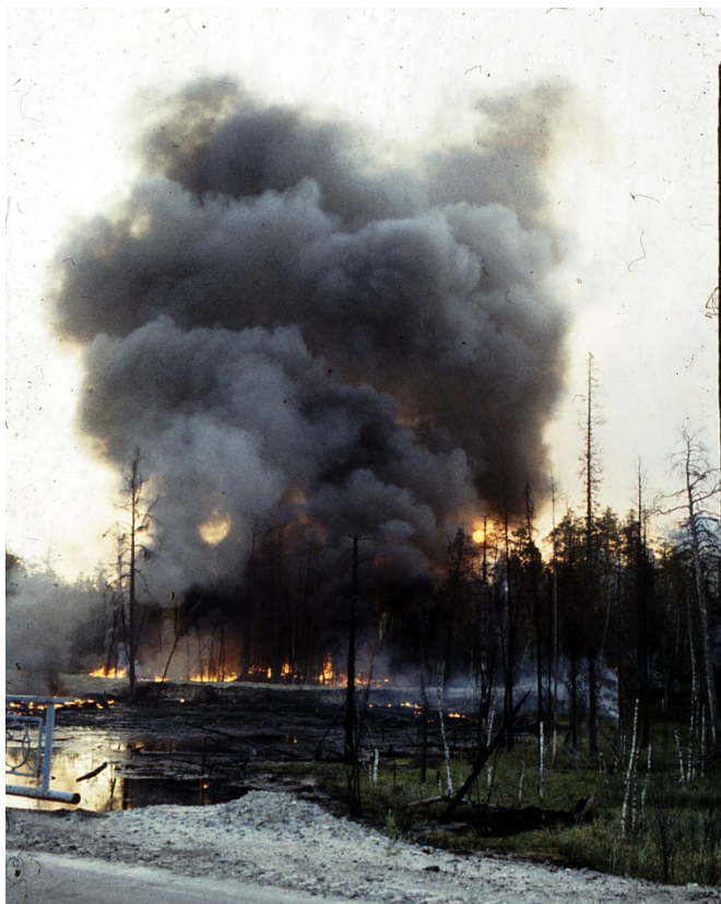
Фото 2. Выжигание нефти с почвы как метод ликвидации аварийных разливов в Сургутском районе часто приводит к лесным пожарам и уничтожению оленьих пастбищ, 1994 г. Фото авторов
