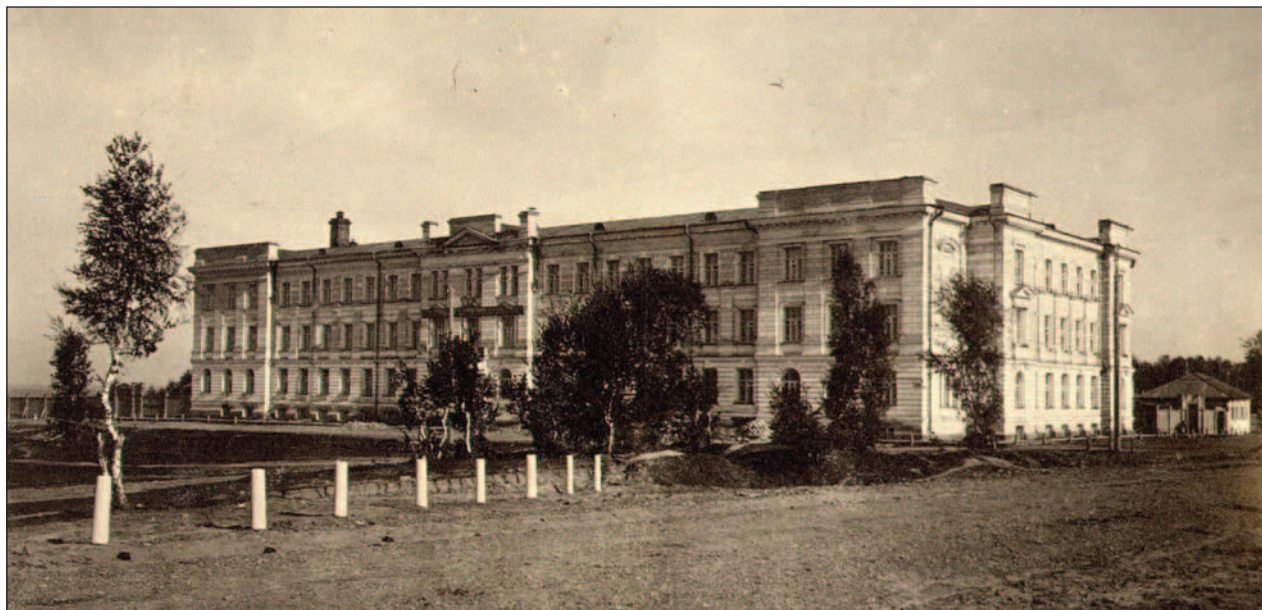
Рис. 4. Госпитальные клиники (1909 г.)
