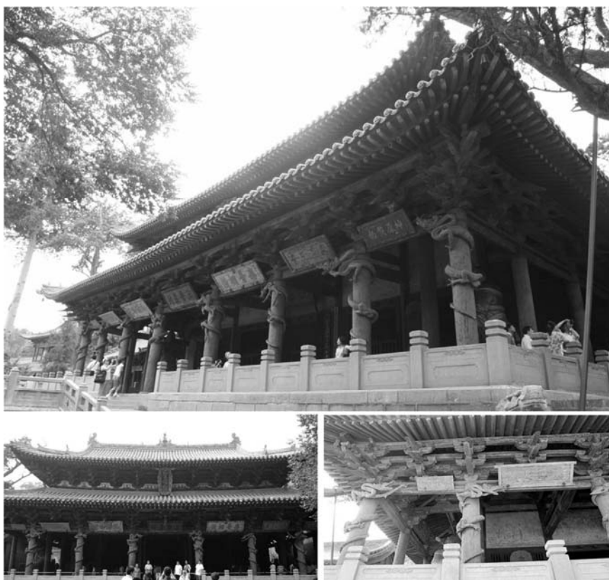
Храм Шенмудянь (1102–1106) в монастыре Цзиньцзы в провинции Шаньси – один из дошедших до нас деревянных памятников архитектуры, построенных с помощью системы доугун
