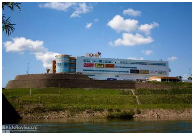
Рис. 1. Габионы. Торговый центр «Июнь». Красноярск
