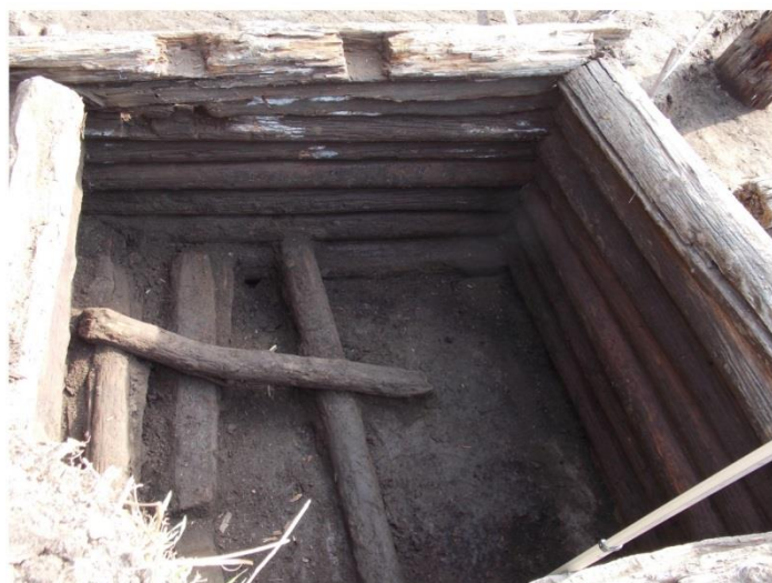
Рис. 2. 1 – погреб «на отлете»; 2 – погреб рядом с избой; 3 – лаги пола и врубки перекрытия во втором погреб
