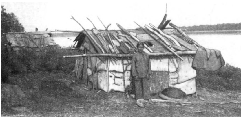
Рис. 32. Ульчский четырехстенный летник, крытый корой даура [1.2.26] (Попов 1961: 189; Левин, Потапов 1956: 821)
