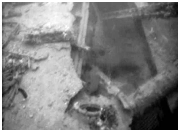
Вскрытый участок палубы с хорошо видимой подачной трубой на переднем плане
